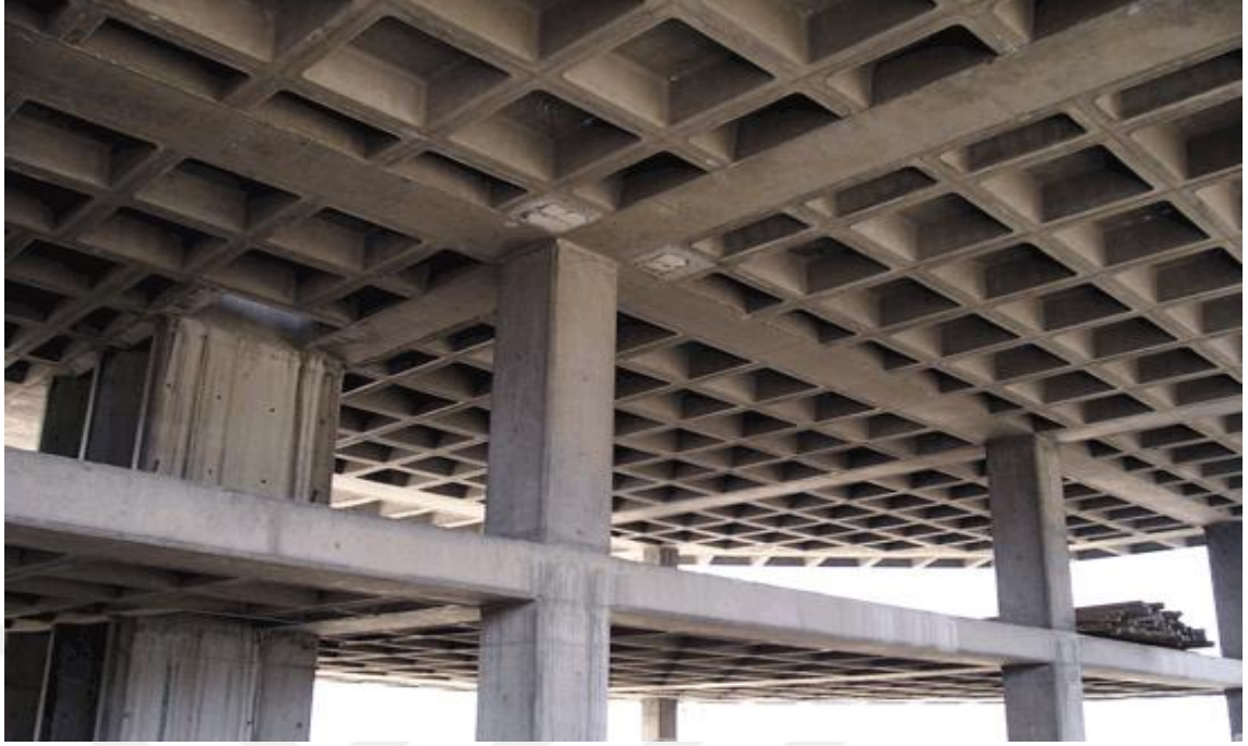
Şekil 3.10. Kaset döşeme kalıp planı (URL-4).
