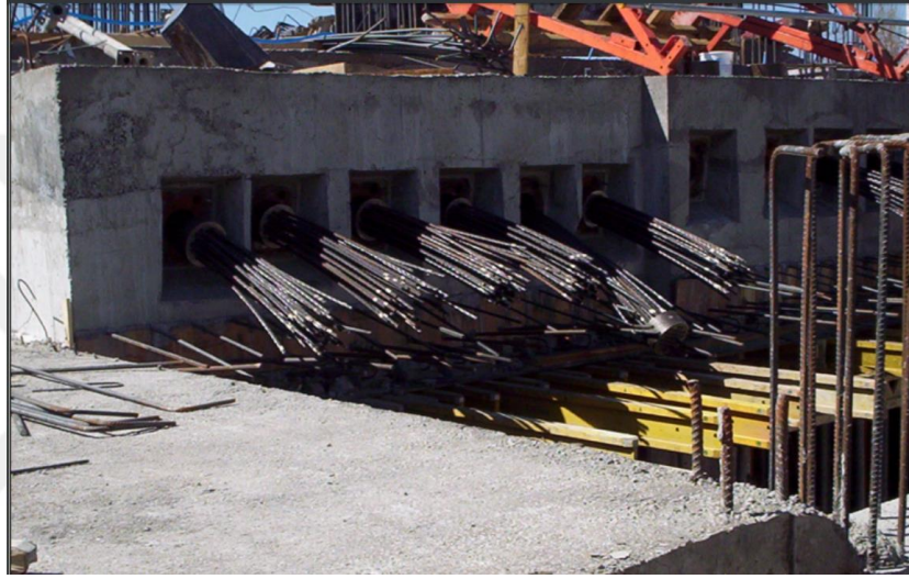
Şekil 4.12. Ardgerme yapılacak halatlar (URL-3).
