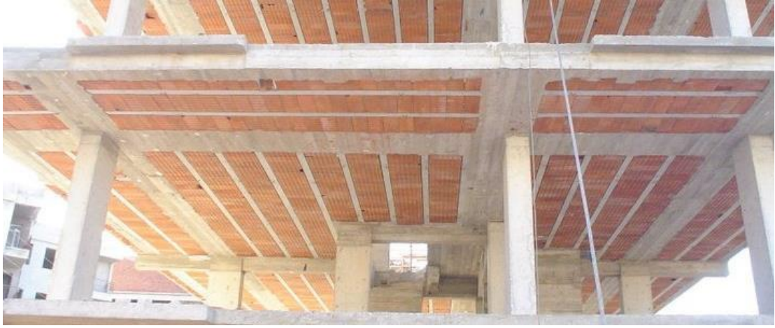
Şekil 3.9. Asmolen döşeme kat planı (Topçu, 2018).
