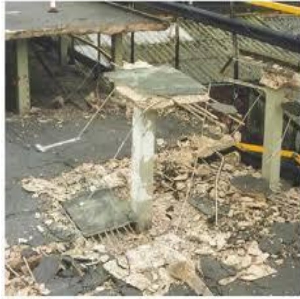
Şekil 4.4. Kirişsiz döşemede zımbalama etkisi örneği (URL-6).
