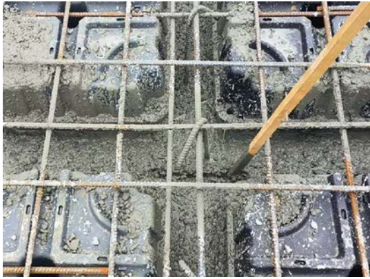
Örnek 4: Betonun plastik kıvamına gelmesi ve ikinci döküm
