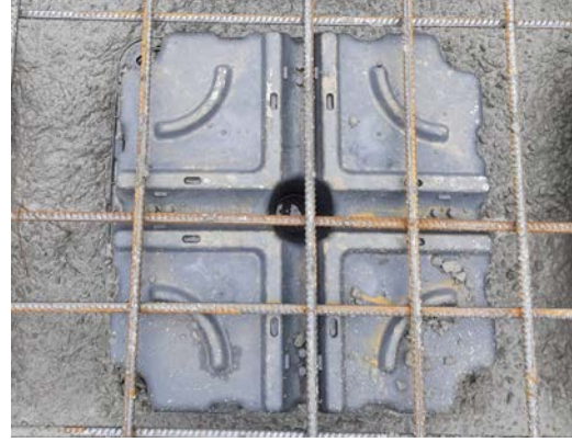
Örnek 3: Kör kalıpları telle bağlama ve merkez koniden beton dökümünün kontrolü
