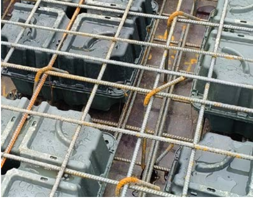
Örnek 3: Kör kalıpları telle bağlama ve merkez koniden beton dökümünün kontrolü
